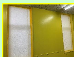
プールへの昇降階段口は完全密封です。
